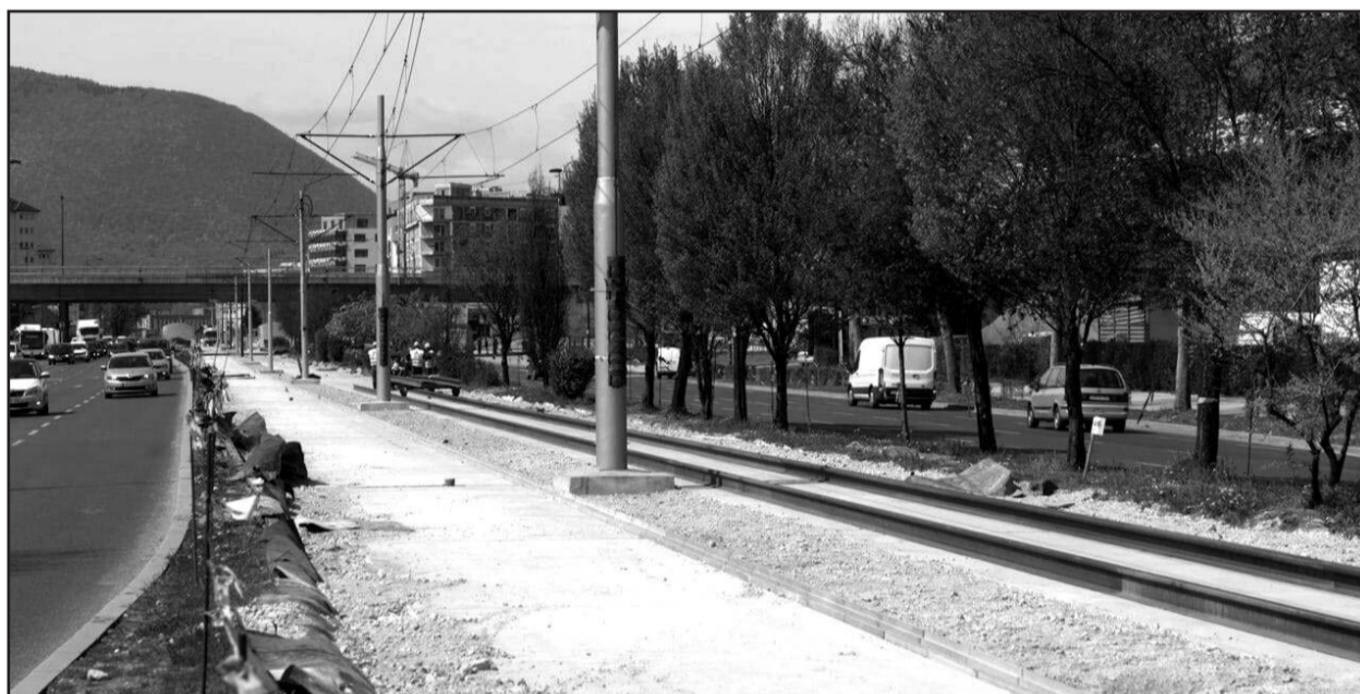
Rekonstrukcija šina u Sarajevu
