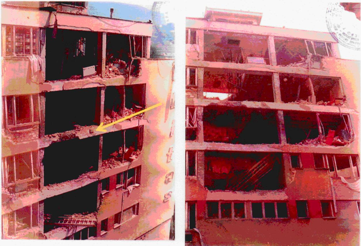
Probijeni su dijelovi vanjskih zidova nasuprot tački udara na četvrtom i petom spratu (slika iz dokumenta 00374967).
