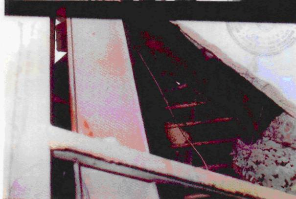
Sama struktura zgrade, sa mnogo uglova je izazvala pojačano djelovanje reflektovanog pritiska, tako da su nastupila značajna oštećenja objekta.
