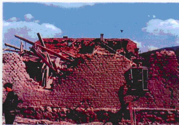
Projektil je pogodio spoj između prozora i spratnih greda, prošao kroz kuću i djelovao u sobi, u prizemlju, na udaljenosti od tačke upada oko 7 m (vidi se oštećena prozorska struktura). Na osnovu visine spoja prozor-greda (3 m) i udaljenosti tačke gdje su nađeni motori (7 m), moguće je procijeniti upadni ugao (sl. iz dokumenta 00334748). Upadni ugao je oko  $25^{\circ}$ .
