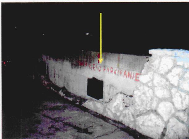
Uvidom na licu mjesta, može se zaključiti da je projektil poslije udara u vertikalni zid Kotlovnice, na visini od oko 3m iznad asfaltnog puta, eksplodirao u prostoru između Kotlovnice i pregradnog zida platoa iznad garaža (crveno bijeli krug).
